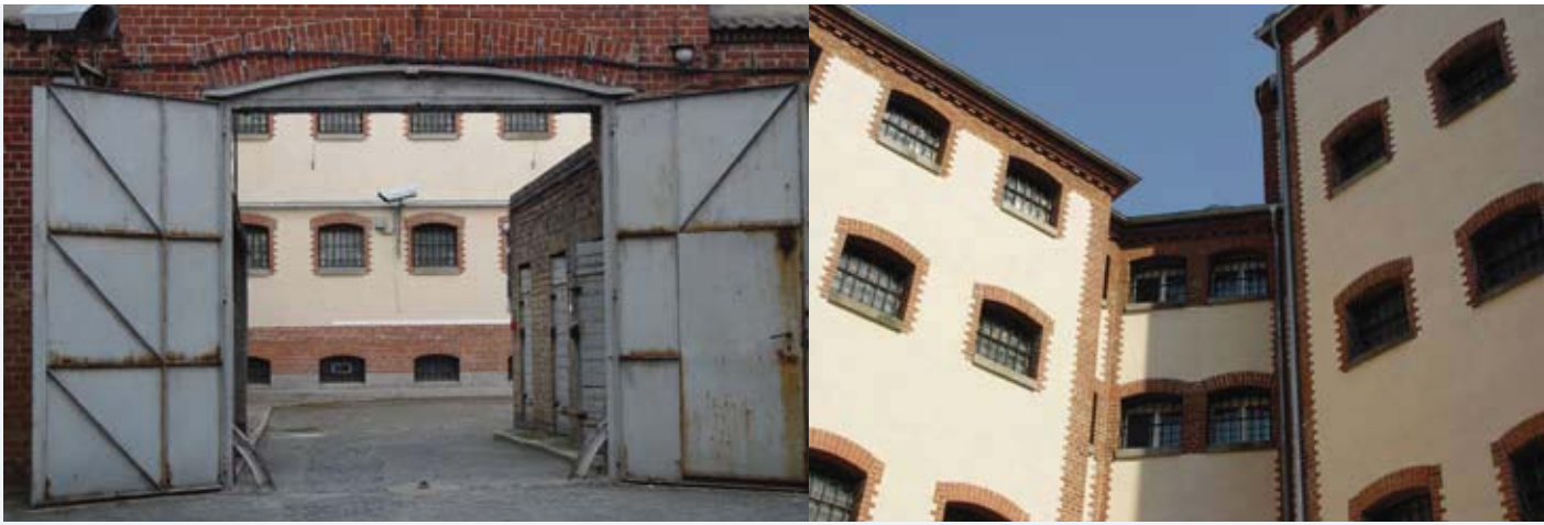
Im Gerichts- und Haftgebäude in der Potsdamer Lindenstraße 54/55 waren von 1952 bis 1989 mehr als 6.800 Menschen im Stasi-Untersuchungsgefängnis inhaftiert.
