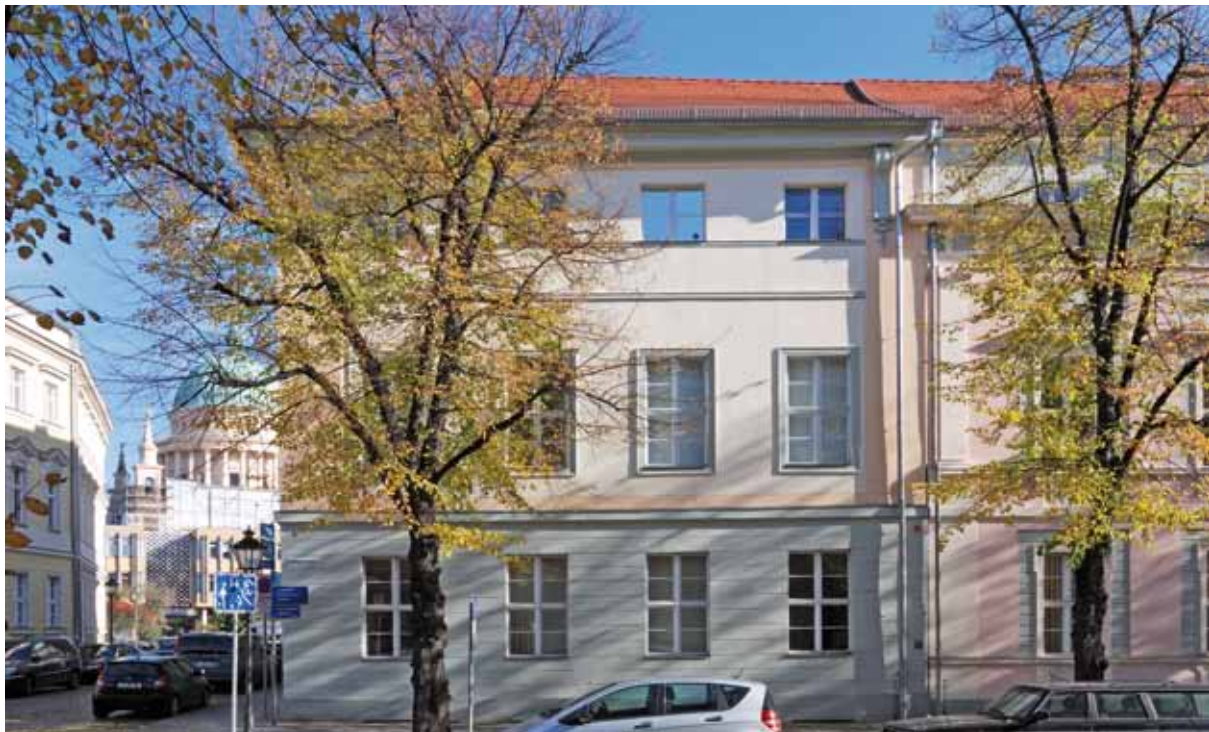
Seit 2001 ist das Gebäude Am Neuen Markt/Schwertfegerstraße der Hauptsitz des ZZF. Das heute denkmalgeschützte Haus ließ Friedrich der Große im Jahre 1753 errichten.
